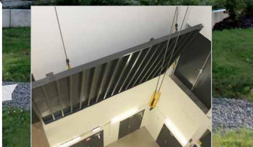
När nya drift/mediecentralen vid Höglundssjukhuset i Eksjö skulle byggas blev Svero Lifting kontaktat. Man behövde en hållbar lösning för öppning och stängning av en golvplattform. Valet föll på Sveros Eltelfrar och kättingkomponenter. Driftschef Tomas Titus är nöjd med lösningen.
